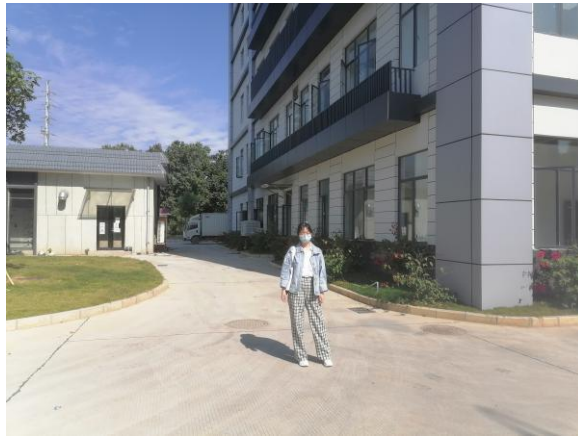
项目西面中途应急污水处理站 附图 3 项目四至环境现状照片
