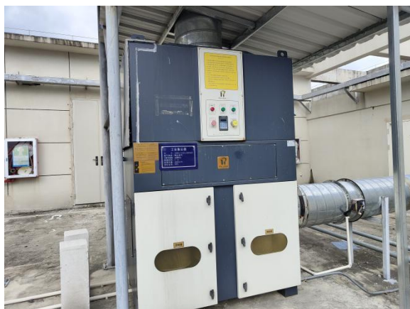
熔铸烟尘处理设施：布袋处理器
