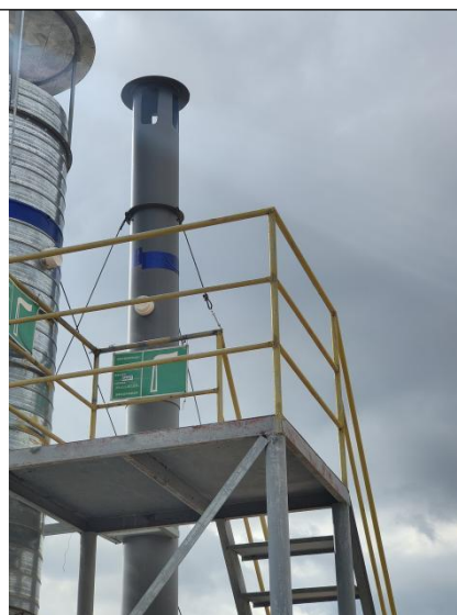
废水处理站臭气排放口 DA007
