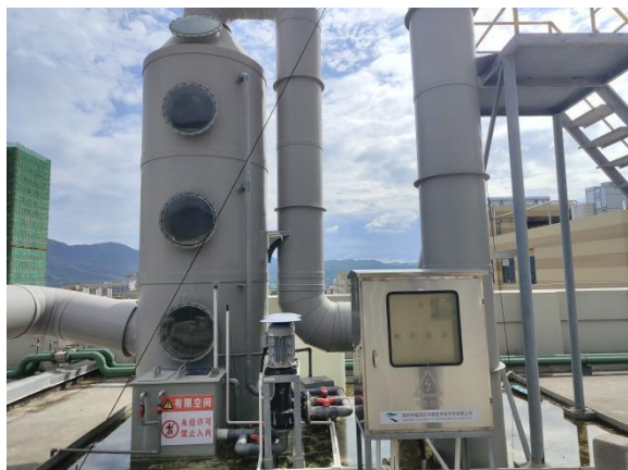
酸洗废气处理设施：碱液喷淋塔
