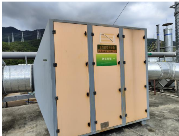
有机溶剂清洗废气处理设施：冷凝回收+UV 光解+ 活性炭吸附
