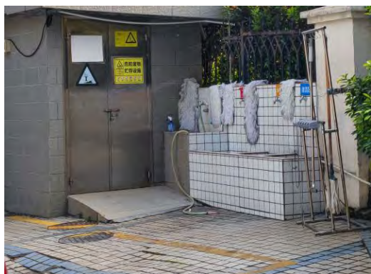
危险废物暂存间前地面硬化
