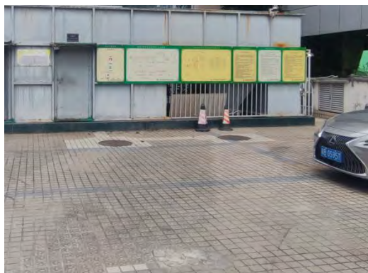
污水站前地面硬化
